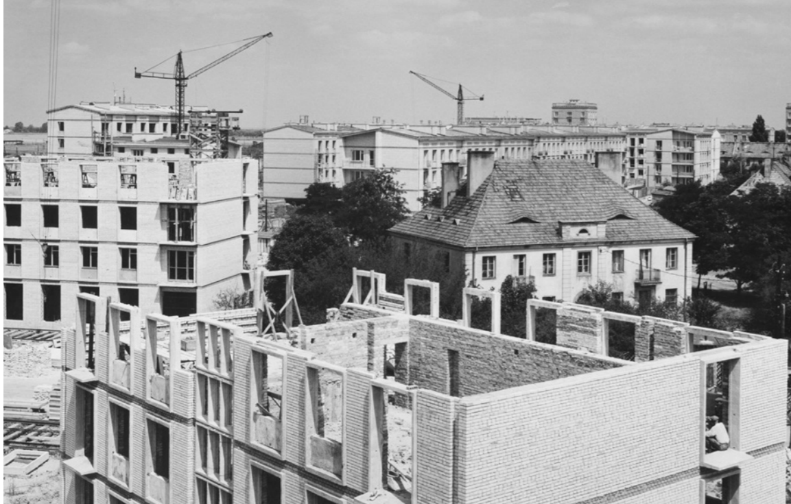
↑ Budowa osiedla Bielan I w rejonie ulicy Skalbmierskiej. Fot. Edmund Kupiecki/ z archiwum M. i K. Piechotków
