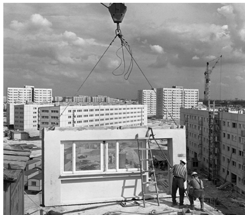
← Montaż budynków z gotowych elementów na osiedlu przy ulicach Starej Baśni i Daniłowskiego. Piechotkowie zaprojektowali tu układ urbanistyczny, lipiec 1970. Fot. Marian Sokołowski/PAP
