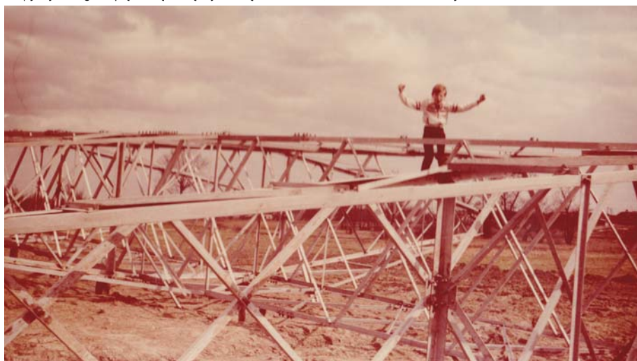
Stupy wysokiego napięcia, łąki między Wólką a Kasiakiem, kwiecień 1983 r. Zbiory B. Antoniewicz ↓
